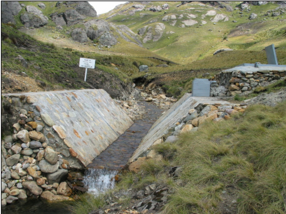
Foto 3-9 Sección Trapezoidal de Control para Medición de Flujo
