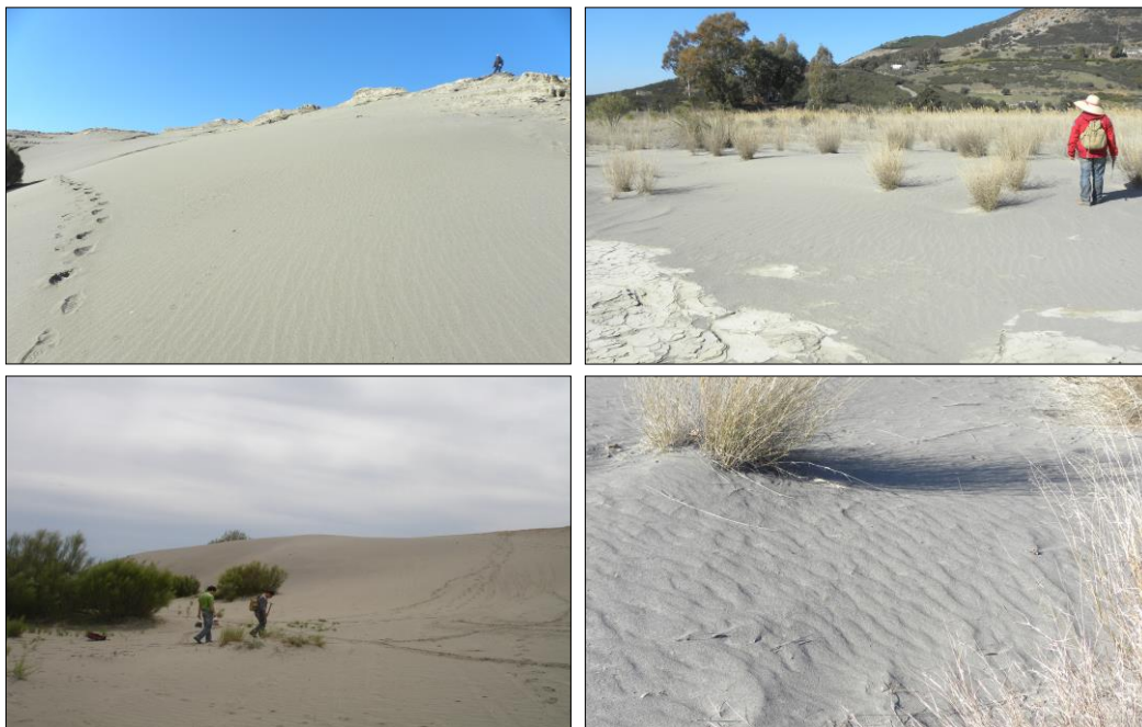
Figura 35. Evidencias de movilización de material particulado por la acción del viento en diversas presas de residuos mineros (formaciones dunares y ripples en diques y plataforma de depósitos mineros).
