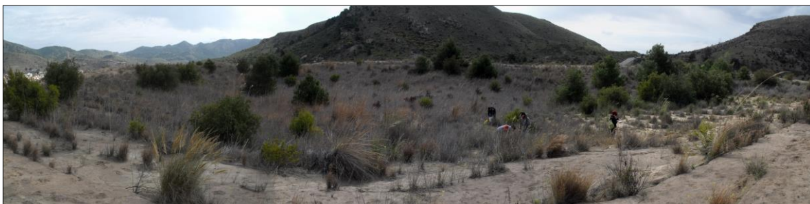
Figura 72. Subsistencia del vaso de una presa de lodos en Portman (Sierra Minera Cartagena-La Unión) por colapso asociado a procesos de erosión interna.
