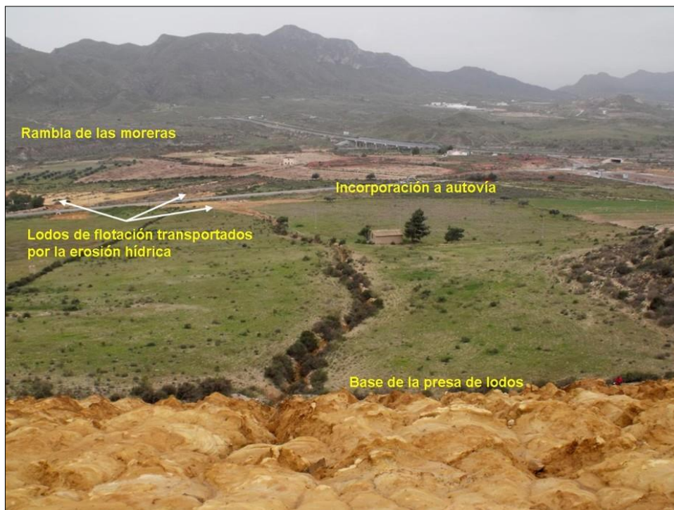
Figura 46. Base del talud de la presa de residuos de flotación San Cristobal II, en las proximidades de Mazarrón (Murcia, febrero de 2011). Se aprecia como la erosión lleva material de la presa por el arroyo y lo deposita en parcelas situadas aguas abajo, lo que se ve favorecido por un cambio de pendiente del terreno.
