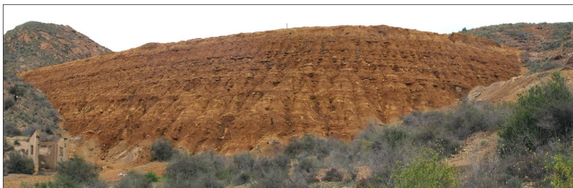
Figura 47. Taludes de una presa de residuos de flotación en las proximidades de Mazarrón (Murcia).
