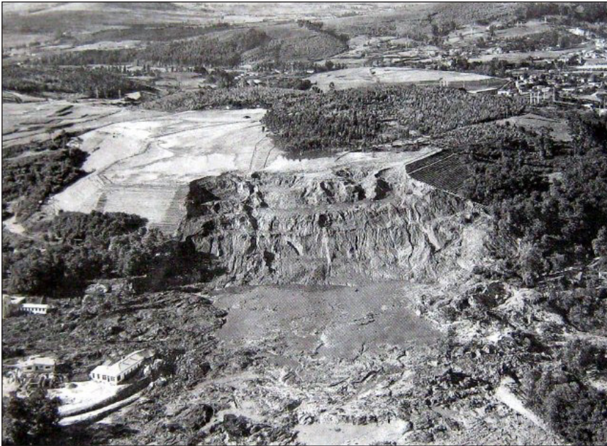
Fotografía 25. Colapso de la presa de lodos denominada Luciana (Torrelavega)
