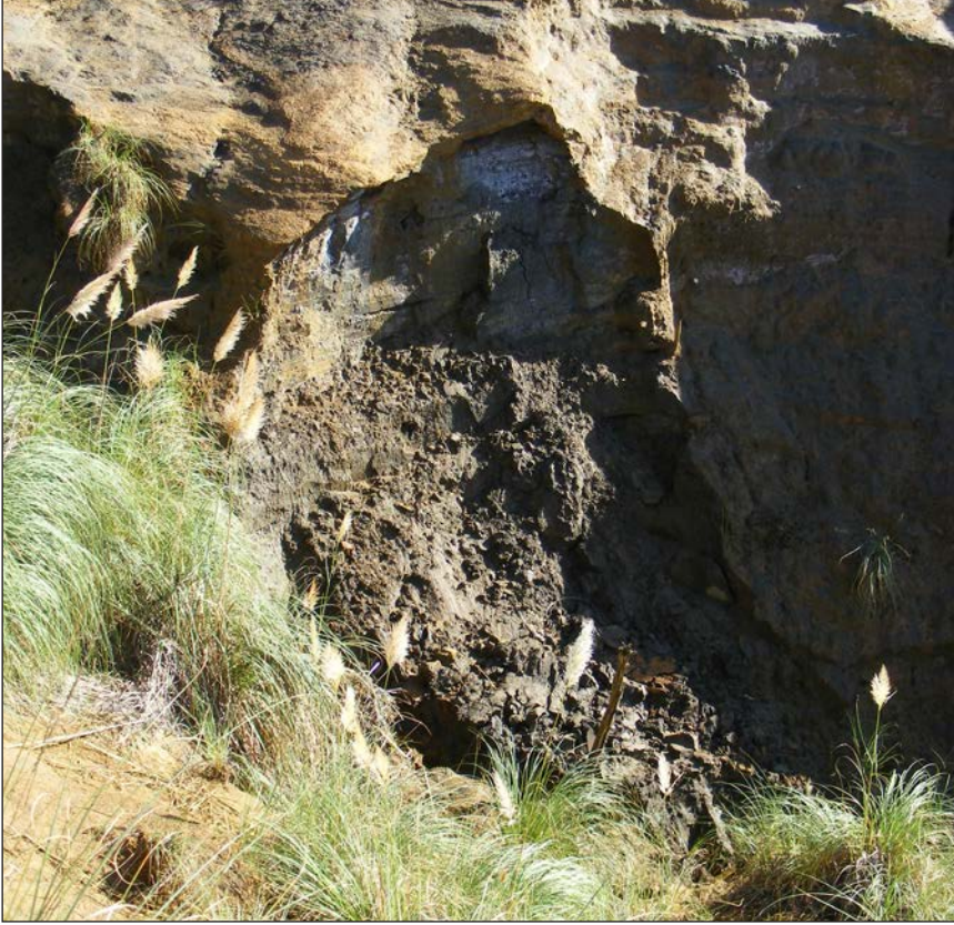
Fotografía 32. Rezumes en dique de lodos
