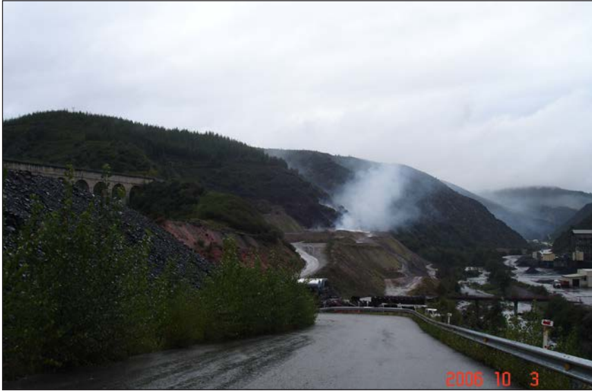
Fotografía 9. Autocombustión de una escombrera de carbón
