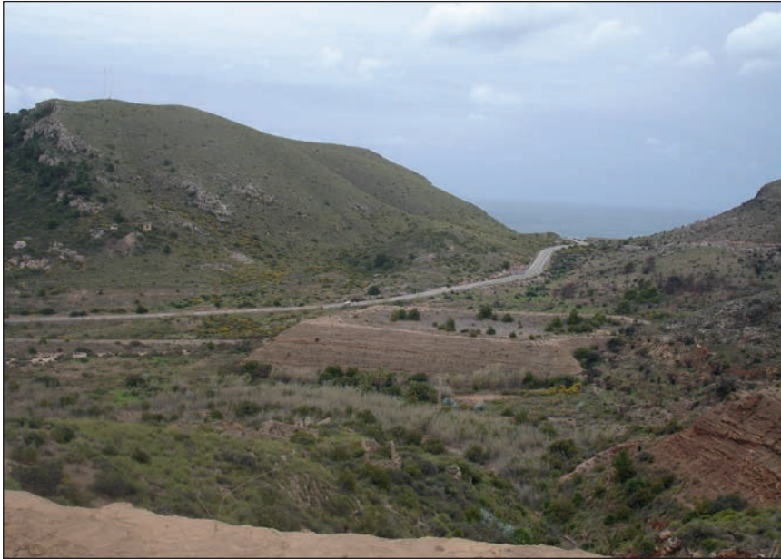
Fotografía 27. Colapso del vaso de una presa por piping debido a la rotura de la chimenea
