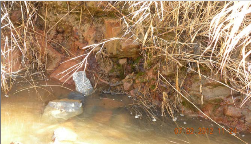
Fotografía 33. Surgencia entre la base de la presa y el cimient (Areniscas del Buntsandstein)
