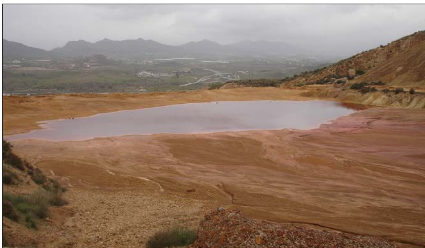
Fotografía 31. Laguna de decantación en presa de aguas ácidas
