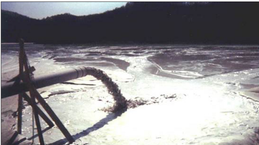
Fotografía 4. Descarga de lodos de flotación en una presa de residuos. Relleno hidráulico de la presa con vertido puntual
