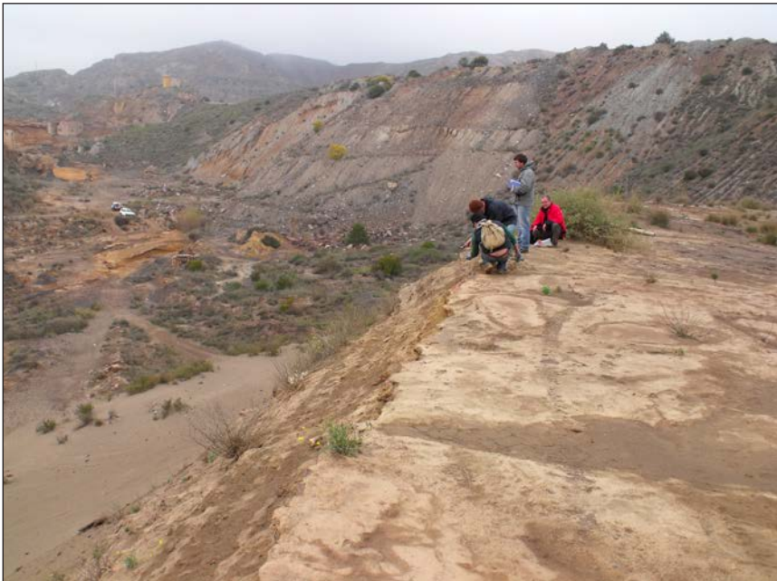
Fotografía 17. Parte superior del dique a la misma altura que los lodos del vaso. Dique de lodos sin ciclonado de arenas
