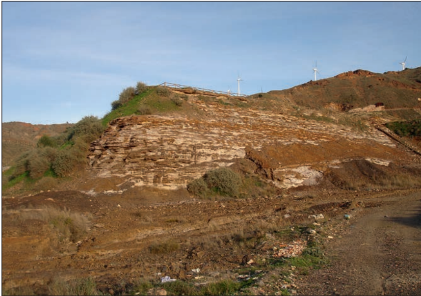
Fotografía 23. Formación de sales solubles el talud
