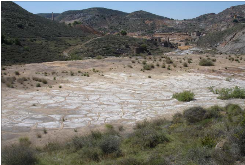
Fotografía 28. Formación de grietas de tracción y diques de arena por colapso del vaso
