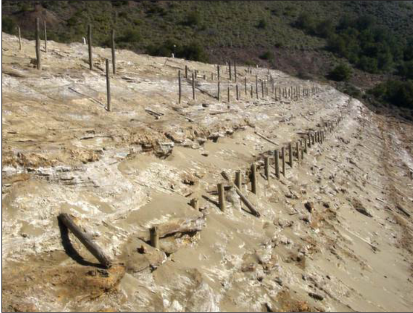
Fotografía 5. Dique construido por el sistema arcaico
