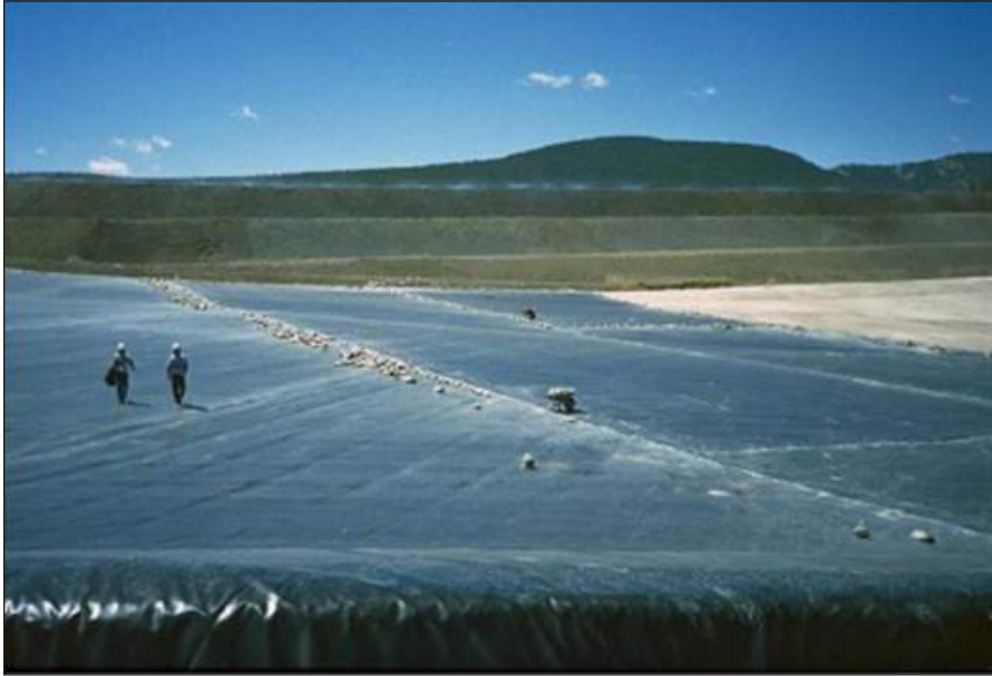
Fotografía 3. Instalación de geomembrana en un pila de lixiviados (Heap leaching)
