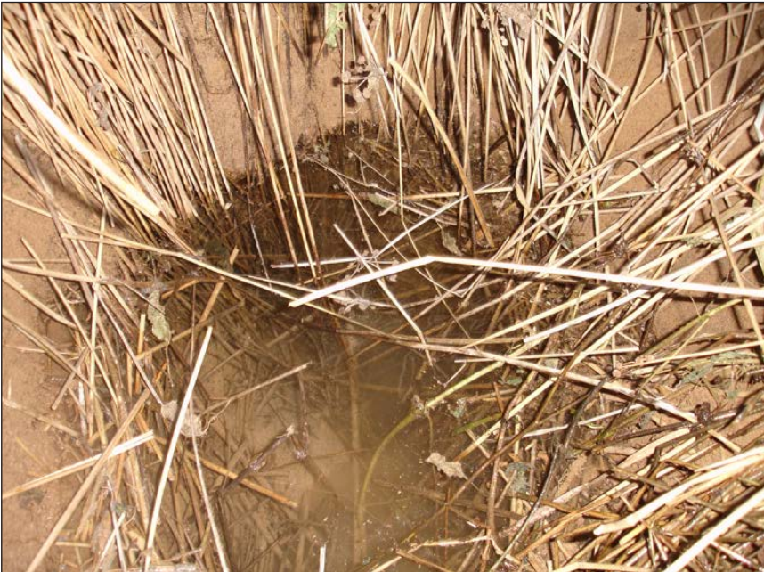
Fotografía 22. Salida de una tubería en el pie del talud de una presa en funcionamiento, conectada con la chimenea del vaso
