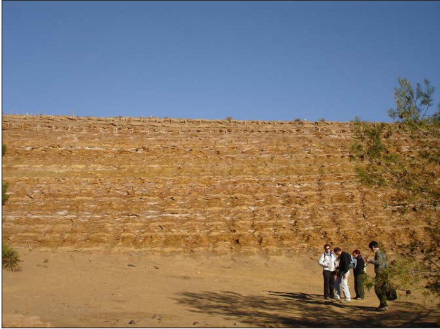
Fotografía 16. Dique realizado con los lodos de flotación por el sistema de tabla-estacas
