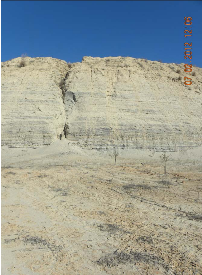
Fotografía 34. Cárcava producida por la apertura de una zanja para desaguar el agua del vaso de la presa
