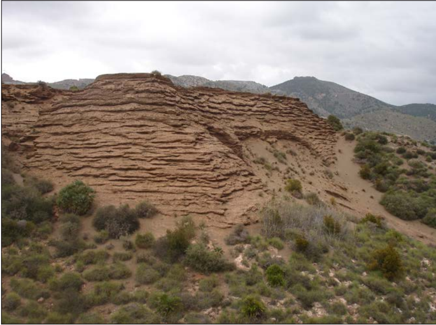
Fotografía 11. Deslizamientos superficiales en talud de presas de lodos
