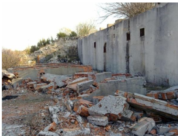
Figura 4.29. Restos de las antiguas instalaciones de la planta de procesado.
