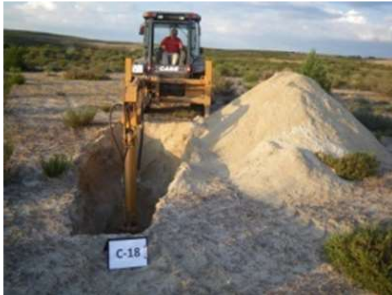
Figura 2.17. Ejemplo de realización de calicata en la Balsa Grande.
