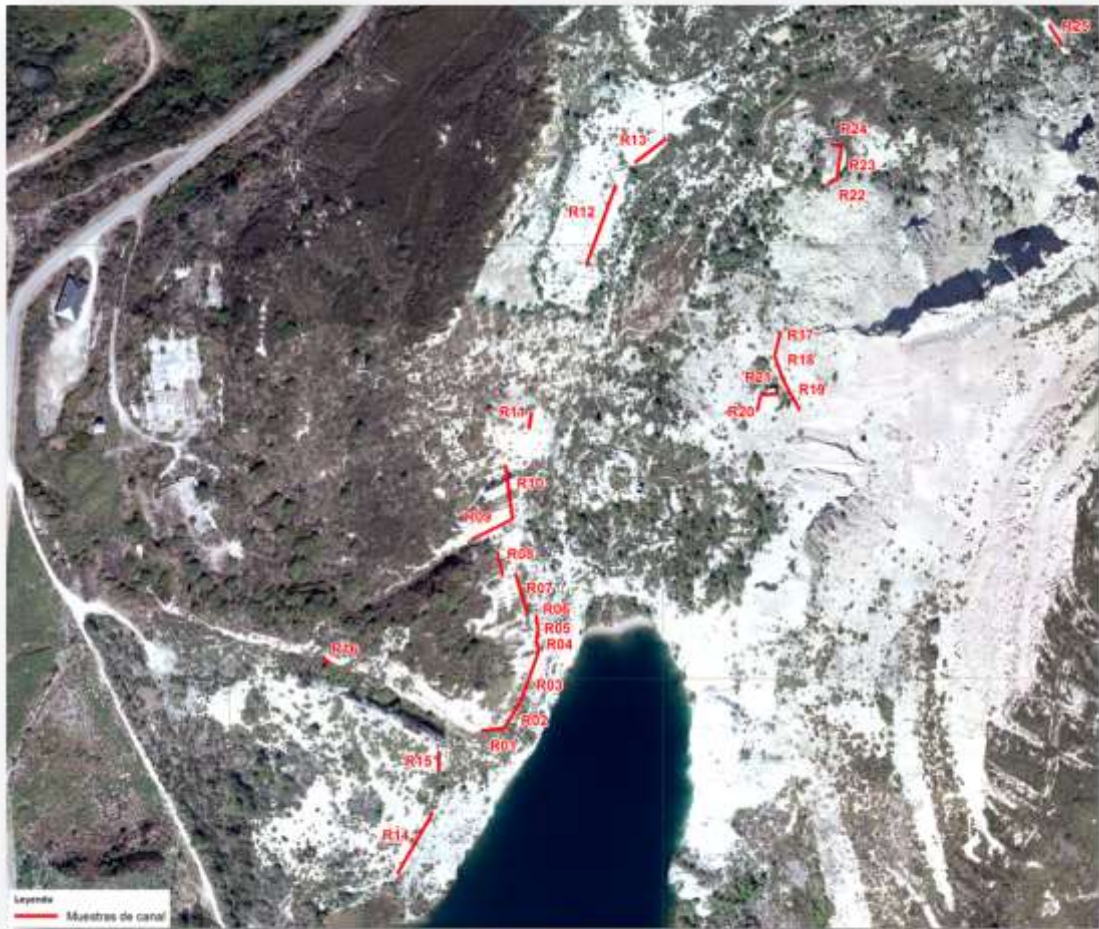
Figura 2.31. Localización de las rozas correspondientes al muestreo en canal de la corta.
