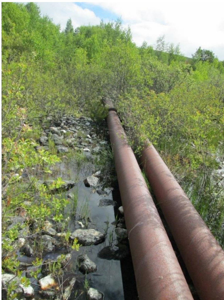
Figura 4.5. Tramo entubado del arroyo Treita de Cortiñas a su salida de la balsa de agua de Roldán.
