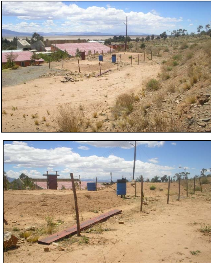
Fotografía 5.4. Vista general de la instalación de las celdas experimentales.
