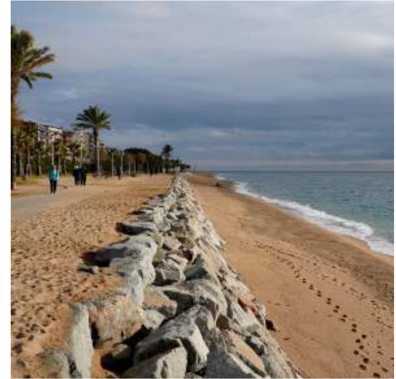
Obras de protección
