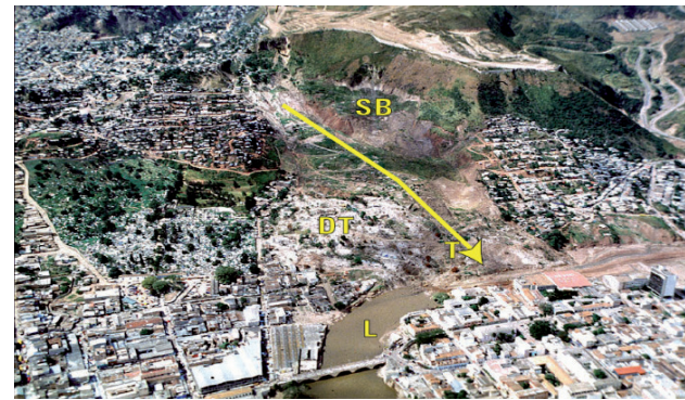
Figura 5. Deslizamiento de tierra en El Berrinche. Flecha: dirección del desplazamiento de tierra; "T": punta del deslizamiento de tierra que represó al río Choloteca; "L": laguna represada por el deslizamiento de tierra; "DT": deformación de la punta; "SB": bloque superior del hundimiento.
