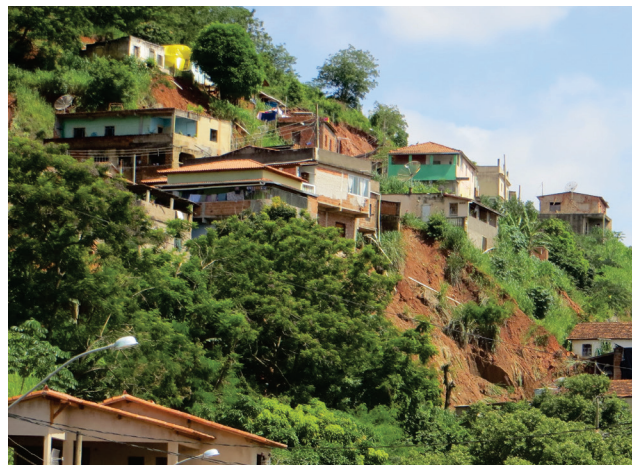
Figura 8. Deslizamentos em taludes de corte no Município de Resplendor.
