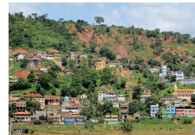
Figura 5. Deslizamentos planares em encosta da margem direita de Resplendor em 2013.
