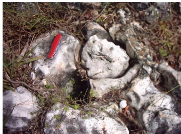
Figura 4. Afloramiento de material en el cuerpo del deslizamiento y formación kárstica en la parte superior.
